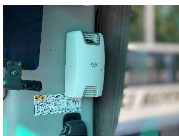
(オゾン発生装置の設置)
